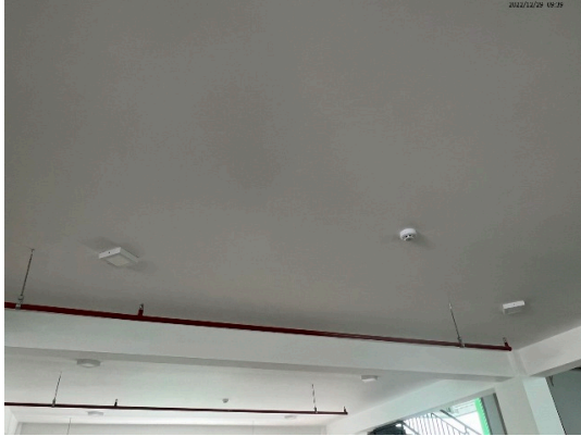
12. Smoke detector system.jpg
